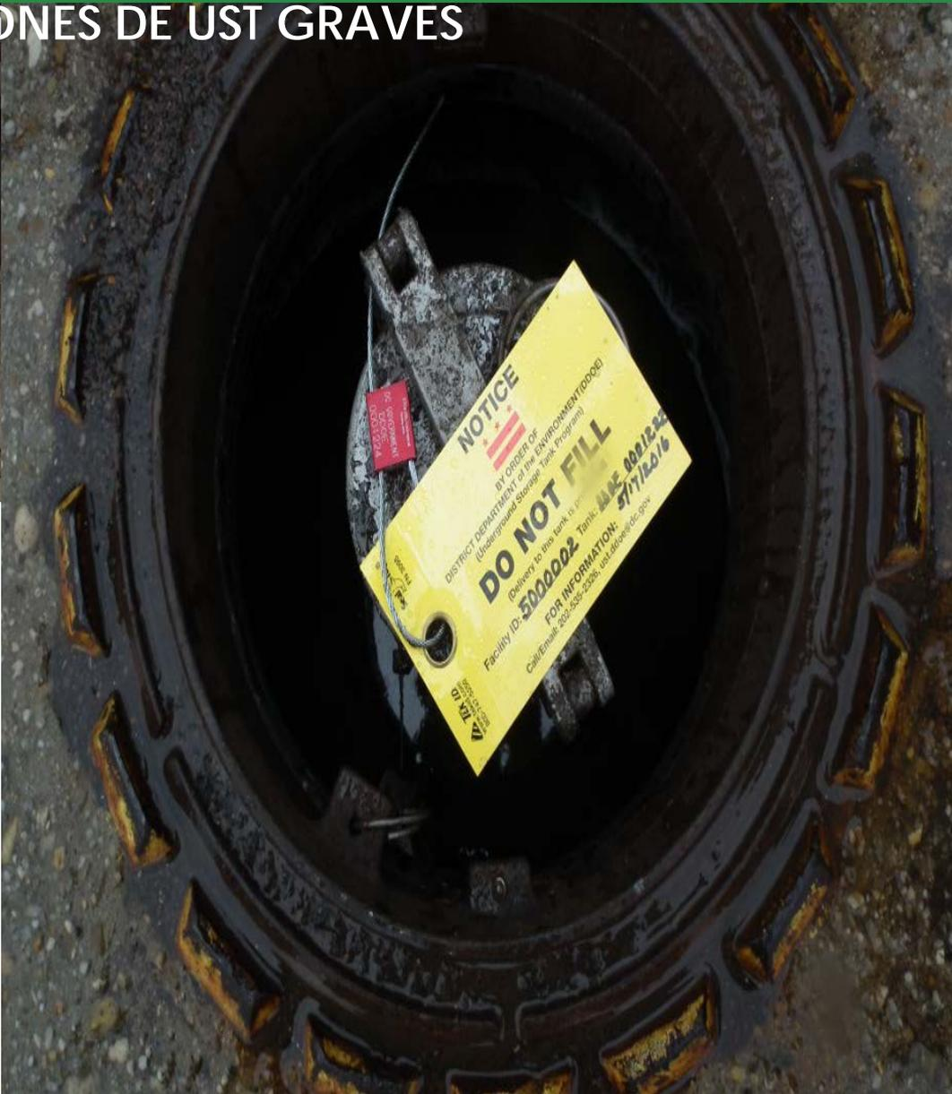
NPS - Instalación de mantenimiento de Brentwood, 515 New York Avenue, NE; etiquetado de galón diésel de 4 mil que se sobrellenó, el martes 10 de mayo de 2016
